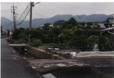
⑦ ①②からつづく用水路
